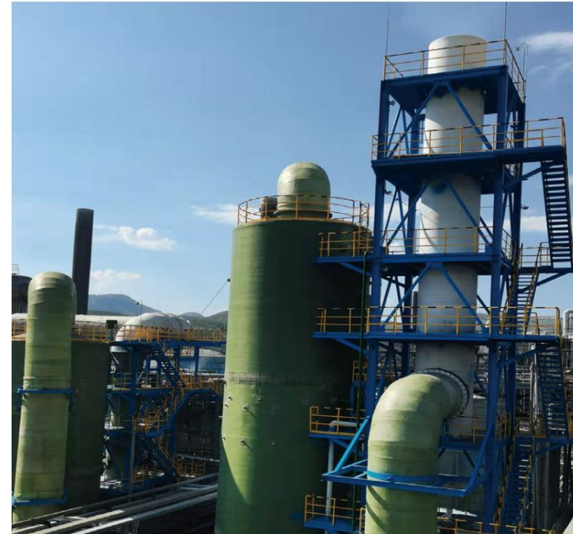
◀ 2021年红磷化工投资1,050万元在原达标排放的基础上,进一步对13万吨/年磷酸装置尾气进行深度治理,治理后装置氟化物浓度大幅降低(氟化物 $<5\text{mg}/\text{Nm}^3$ ),烟囱白雾明显消除。
